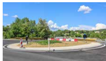
le nouveau rond-point au pont Valentin, entre Vaison et Crestet.
